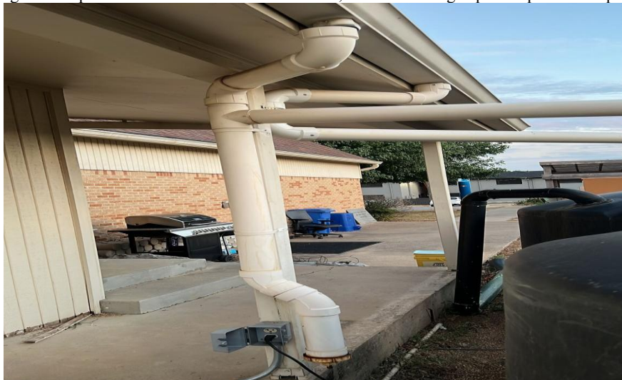
Figura 3: A partir de um sistema de tubos de PVC, canaliza-se a água pluvial para os tanques.
