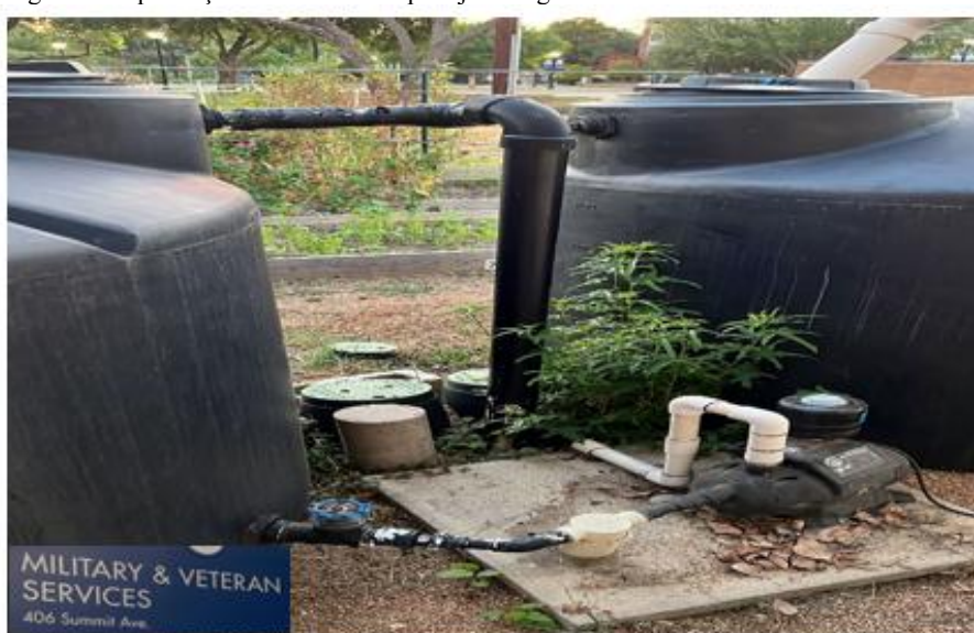
Figura 4: Implantação de uma bomba para jorrar água em locais mais distantes da residência.
