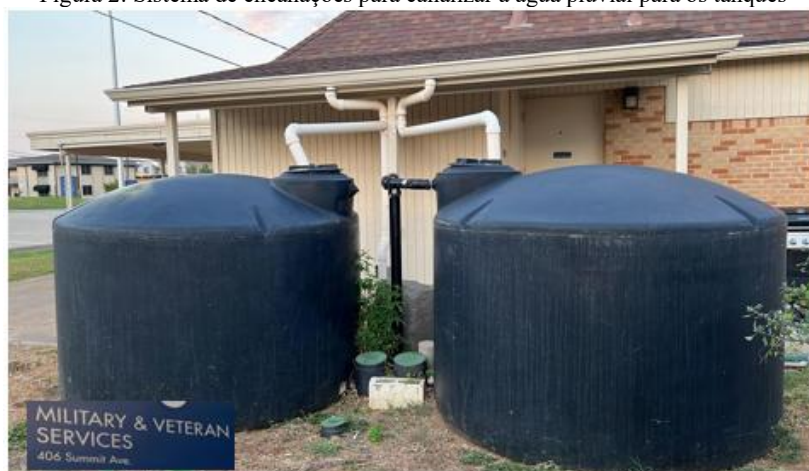
Figura 2: Sistema de encanações para canalizar a água pluvial para os tanques
